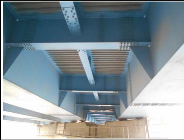
Steel Box 및 가로보
